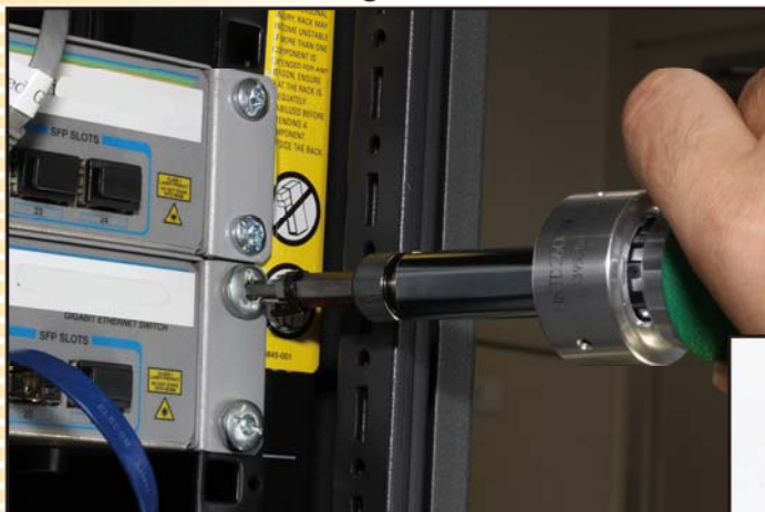
Linsenkopfschraube M4 mit blauer Markierung
